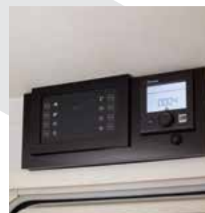
Elektronisches Kontroll Panel (Ausser Starlett) Electrical control panel
